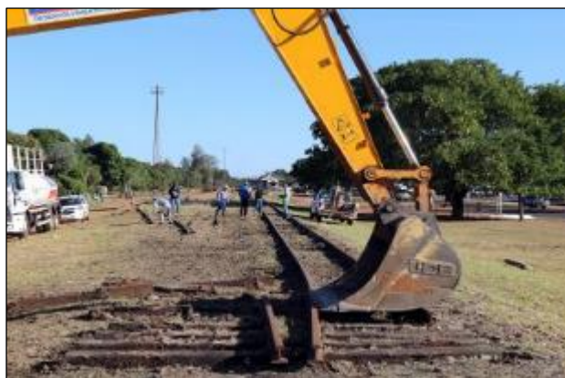
Foto 6 – Início das obras de construção do galpão para a nova instalação da Feira Livre (2019). Fonte: Três Lagoas (2019).
